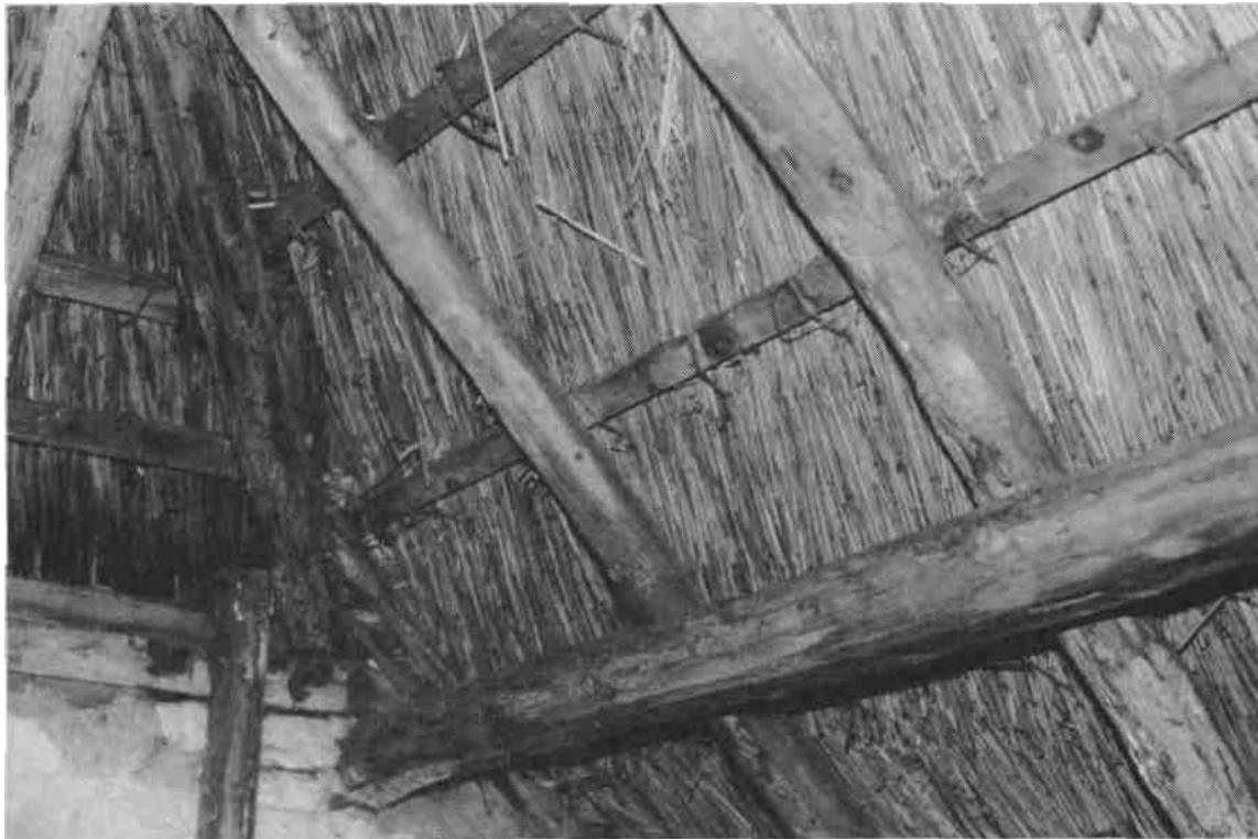
Rietendak. Dakconstructie, met "geschilde" ronde daksparrren.
