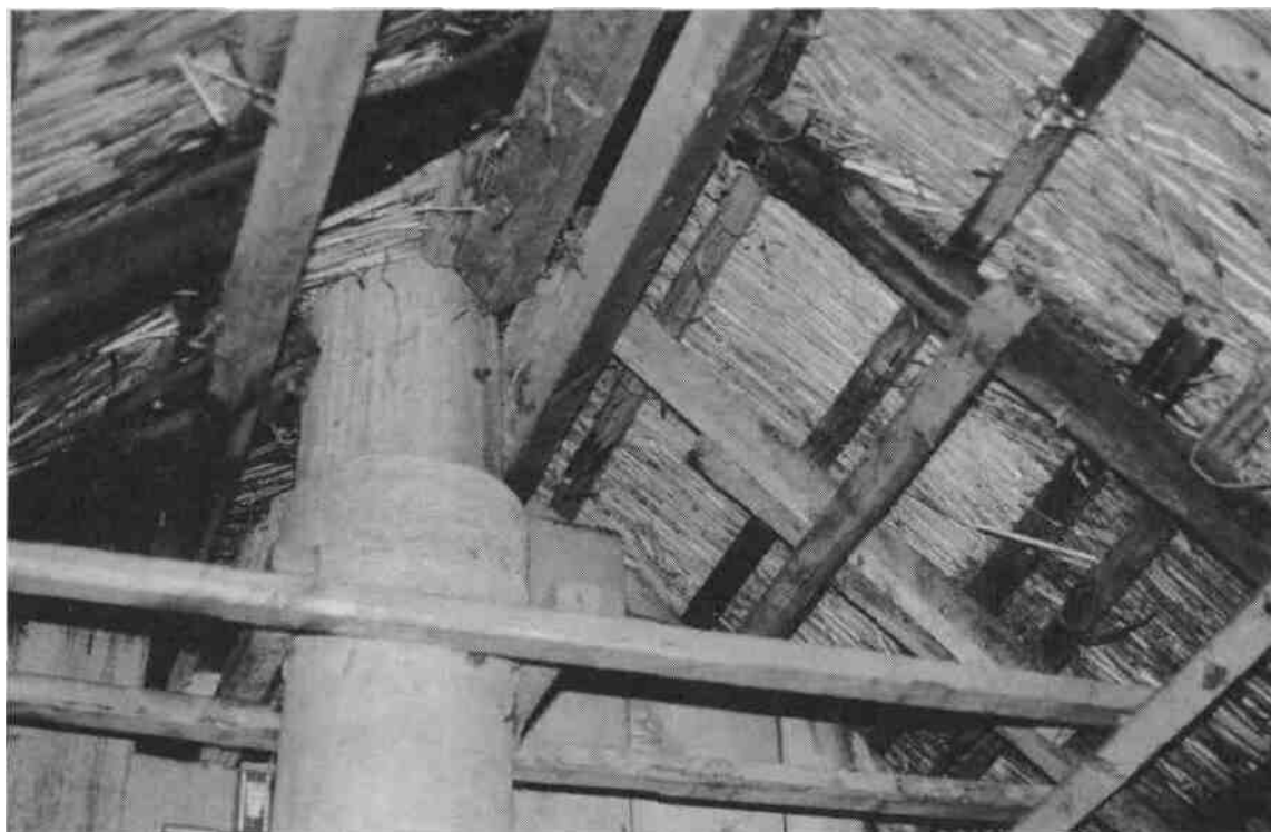
Vernieuwde dakconstructie, met rookkanaal.
