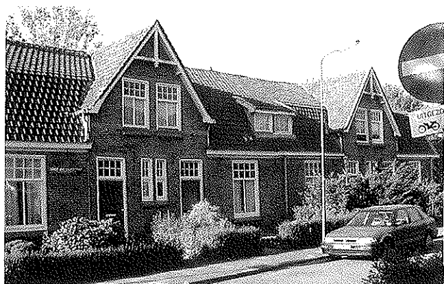
De woningen in de Graaf van Solmsstraat anno 2000.
