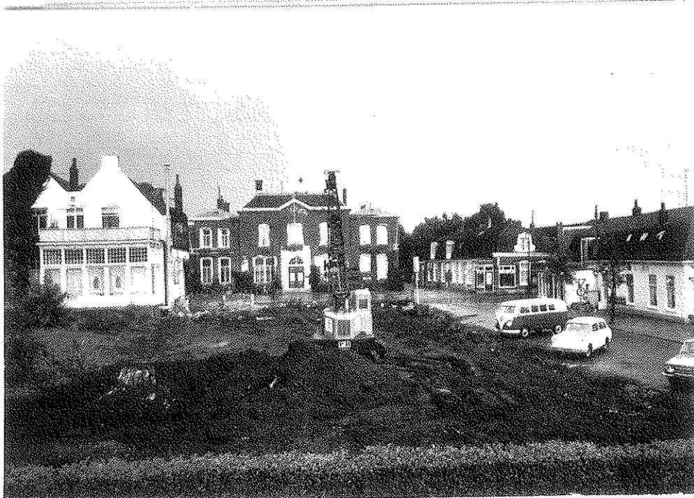
De Raadhuislaan anno 1968 met gezicht op het gemeentehuis gezien vanaf de ABNbank. De voorbereidingen voor de bouw van de Amrobank zijn in volle gang. Het complex woningen rechts naast het gemeentehuis is nadien afgebroken.
