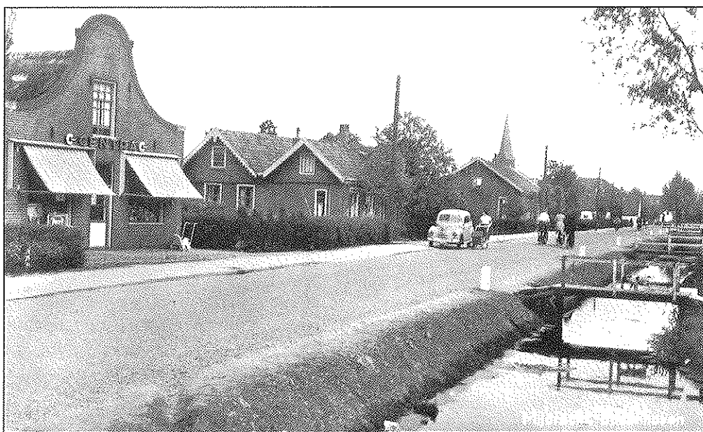
In het pand links op de foto stichtte Joop Reurings zijn eerst kruidenierszaak in Mijdrecht. Enige jaren later kocht hij het pand van Kaatje Hak waar de groei van zijn zaak begon. Links naast het (inmiddels afgebroken) pand met de klokgeval staat het huis van bloemisterij Wiegmans. (Foto ter beschikking gesteld door Mevrouw Reurings)
