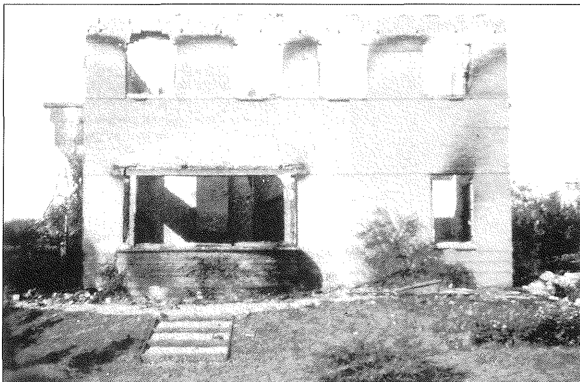
Alleen de muren bleven staan
