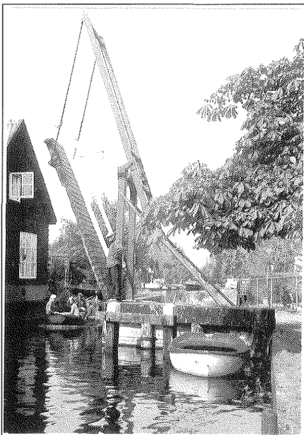
Hoe zat het met de nummering van bruggen en bruggetjes? Alleen maar een naam? Zoals hier De Geuzenbrug?
