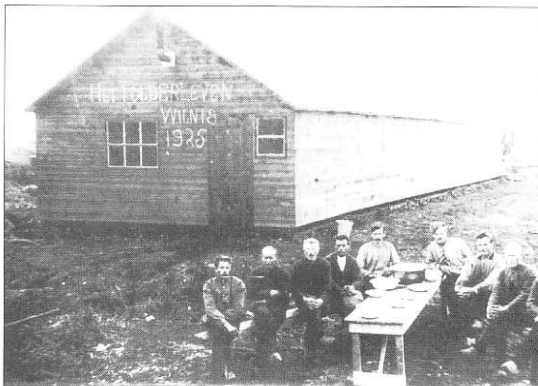
Na de droogmaking wordt een begin gemaakt met het egaliseren van het land. Daartoe werden grondwerkers uit Friesland aangetrokken. De foto toont hun onderkomen. Bron: Archief H. van Soest
