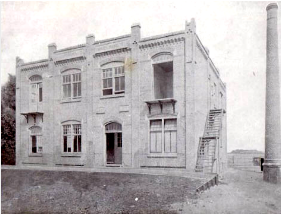
De stoomzuivelfabriek (de latere VAMI) aan de Amstelkade in de Amstelhoek. (foto uit de collectie van Jan Compier)
