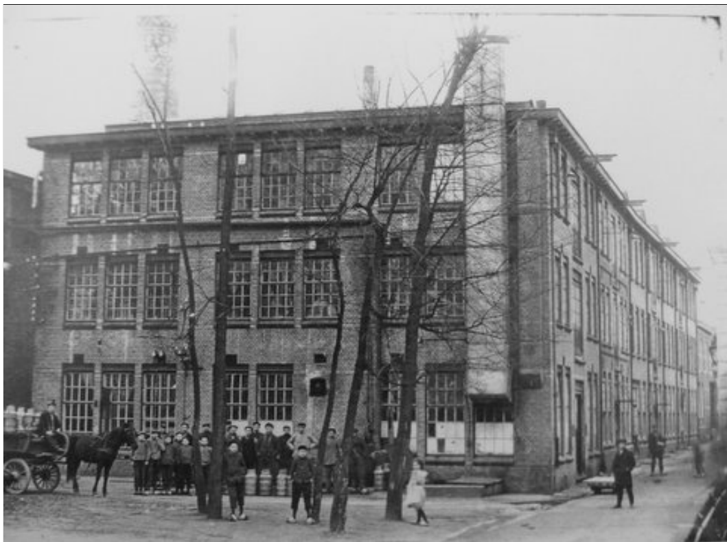
Achterzijde van de biscuitfabriek De Lindeboom. De enorm hoge schoorsteenpijp, links, is nog vaag zichtbaar
