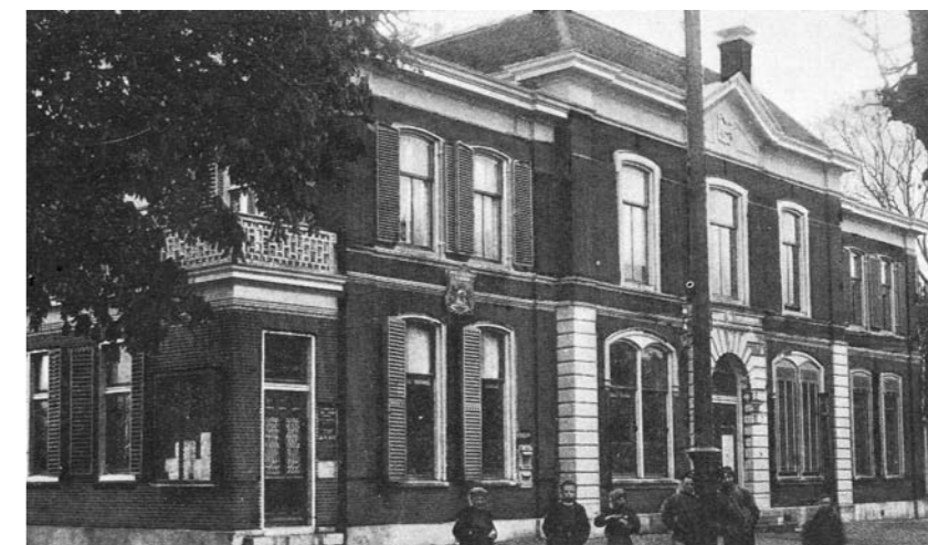
Links in het voormalige gemeentehuis was het postkantoor gevestigd. Later is een aparte ingang voor het postkantoor aangebouwd.
