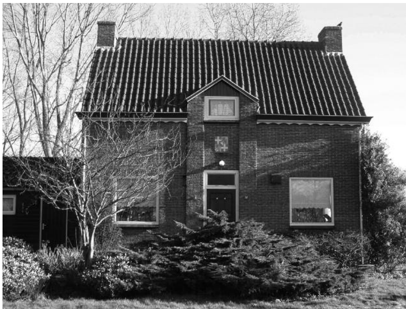
Kantonnierswoning in Mijdrecht
