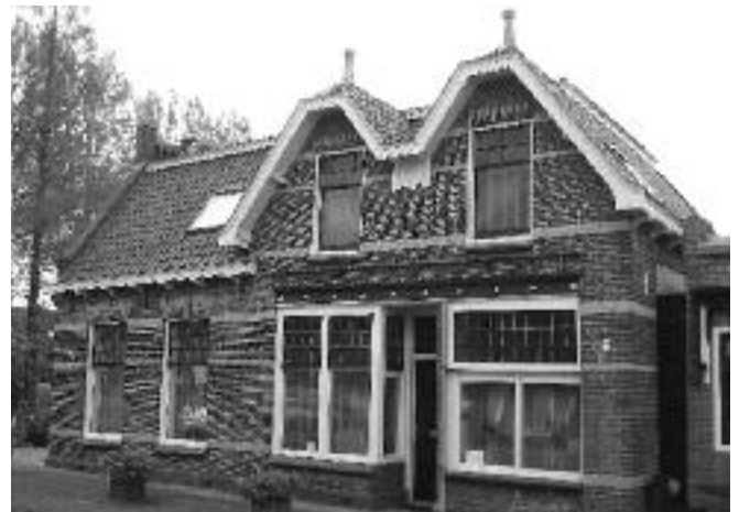
Gemeentelijk monumenten, Dorpsstraat Wilnis. Het linkerdeel nr. 72 werd in 1913 gebouwd in opdracht van de heer van Sevenhoven. Het winkelpand rechts nr. 74 met portiek, een jaar later voor E.J. van Schuppen (foto Stef Veerhuis)
