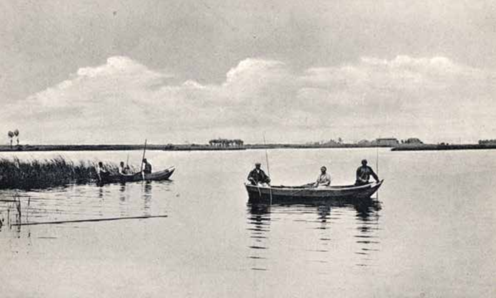
Vinkeveense plassen met rechts zicht op het gemaal aan de Demmerikse sluis
