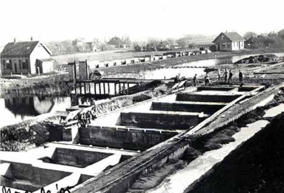
Het leggen van de fundering voor het fort De Kwakel 1905.
