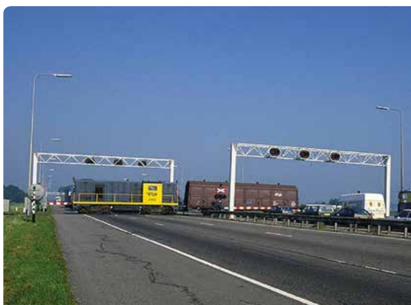
De spoorwegovergang over de snelweg A2 (tot 1986)
