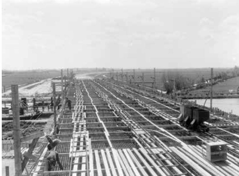
Viaduct over N201 rond 1950
