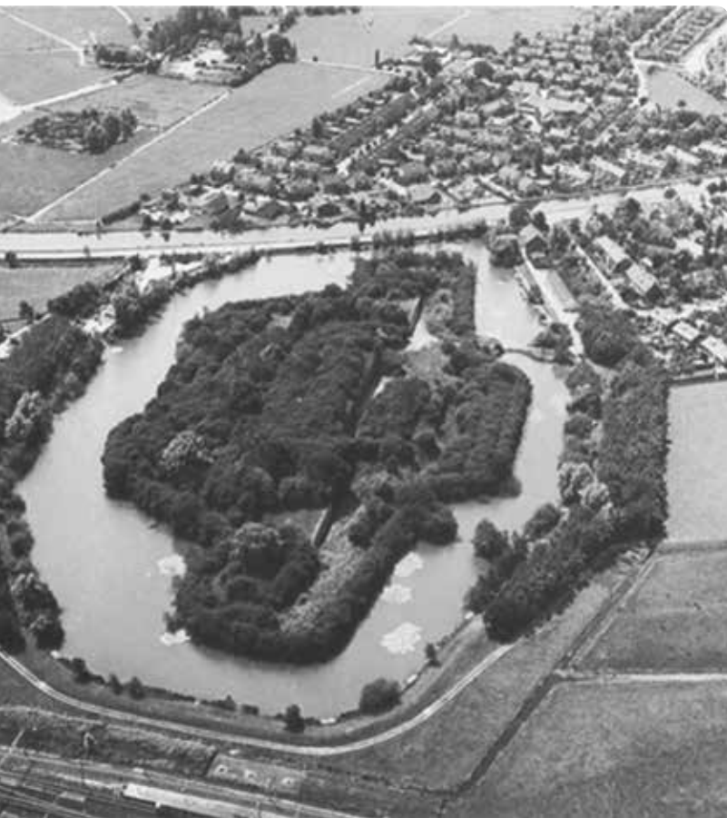
Luchtfoto fort Abcoude, met gezicht op het westen
