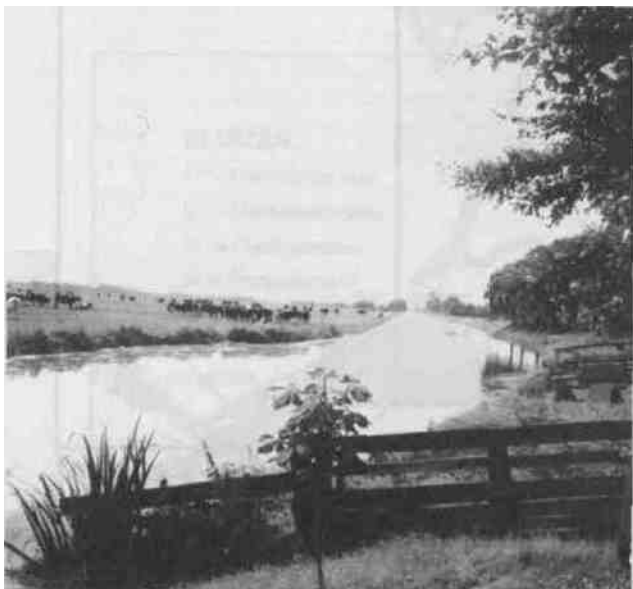
De bocht in de aanvoertocht, ontstaan door de verplaatsing van het gemaal
