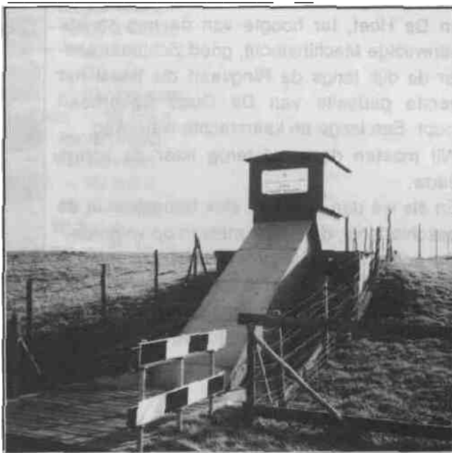
Het kleine gemaal van de 2e bedijking aan de Ir. Verhoefweg
