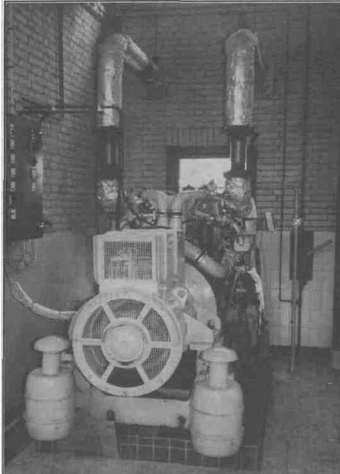
Het diesel-aggregaat uit de dertiger jaren in het gemeaal aan de Amstelkade (Wilnis)
