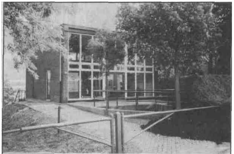
Voorzijde van het uit 1931 stammende gemaal aan de Amstelkade (Wilnis)
