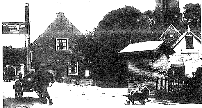
De pomp van het Nut in Abcoude bij de Heinkuitenbrug.
