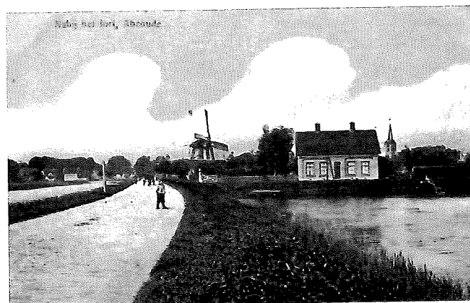
Op de voorgrond de fortwachterswoning nr 18 gebouwd in 1886 Opname begin 20 e eeuw
