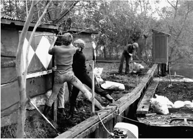
Onderhoud op eiland Ahoy
