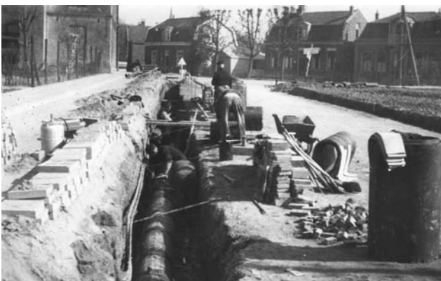
Aanleg riool in Abcoude
